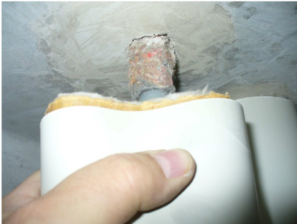
Rohrisolierung KMF-belastet
