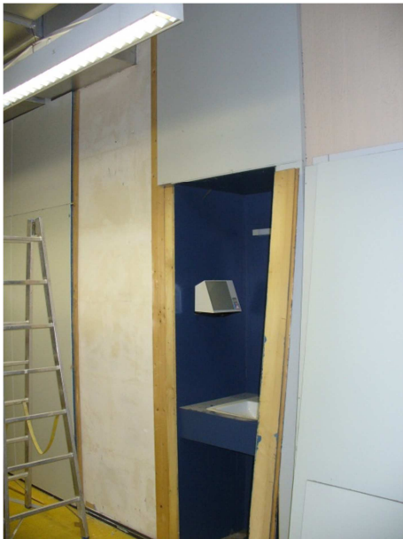
Installationsschacht Technikschacht Ebene 4 MW-Wand asbestfrei
