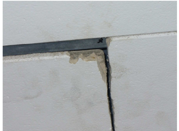
Gepresste Mineralfaserdecke, KMF-belastet
