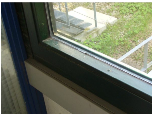
Kitt Verglasung Außenfenster - asbestfrei Beschichtung - keine HSM-Belastung
