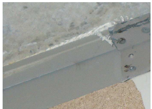
Detail 10 - Paneeltrennwand Asbestschnur oberer Wandanschluss
