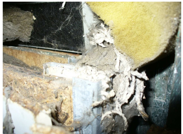
Detail 8 - Paneeltrennwand Asbestschnur Sockel
