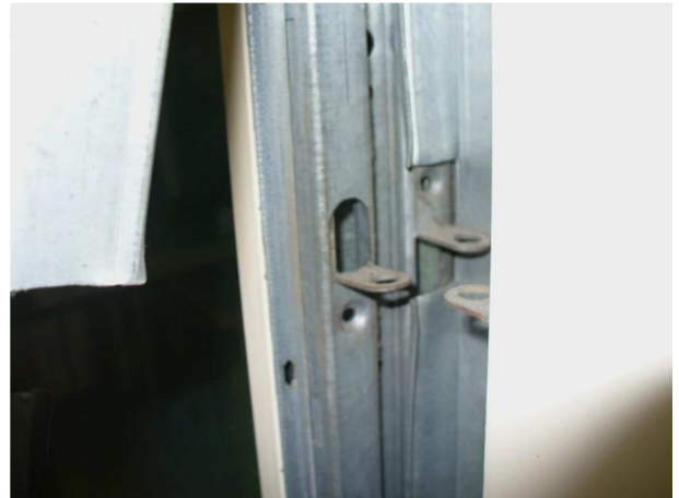
Detail 6 – Paneeltrennwand UK Profile
