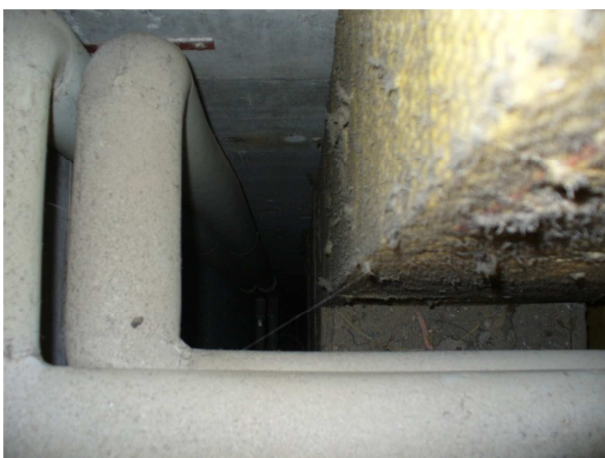
Installationsschacht KMF-belastet
