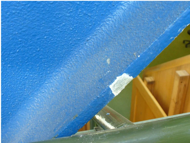
Beschichtung Stahlträger asbestfrei
