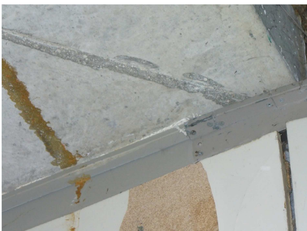
Detail 9 - Paneeltrennwand Asbestschnur oberer Wandanschluss
